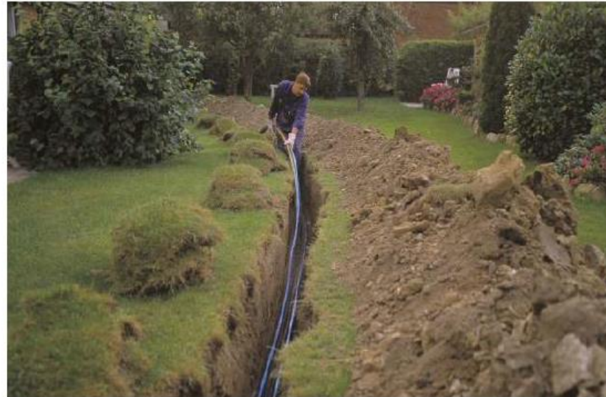
Verlegung einer flexiblen Leitung als Hausanschluss
